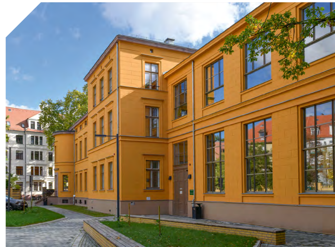
Das Institutsgebäude Geobotanik von der Hofseite aus The Geobotany Institute building from the courtyard
